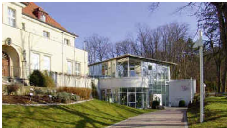
Eingangsbereich nach der Erweiterung 1996
